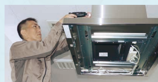
厨房換気扇 取替工事
